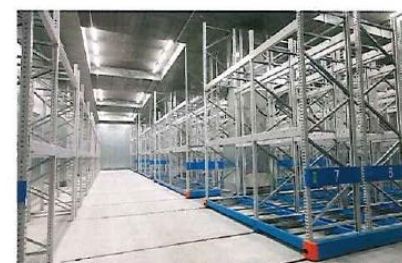
移動ラック式倉庫
