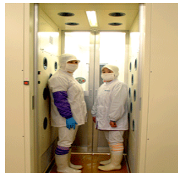
エアシャワー等の衛生管理設備の導入
